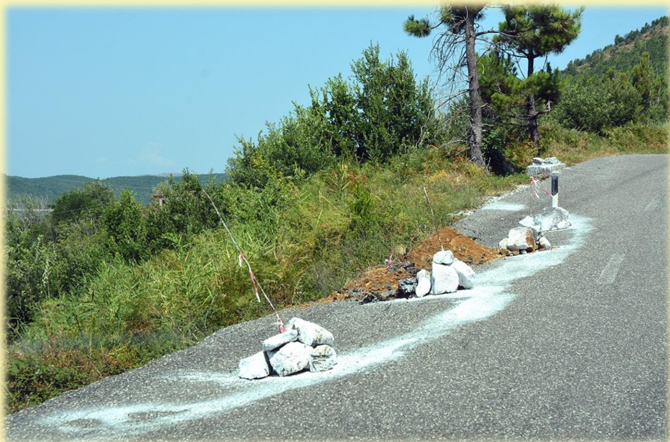
Cesta proti kraju Komani. Bankine niso urejene in opozorilni stožci so precej trdi.
